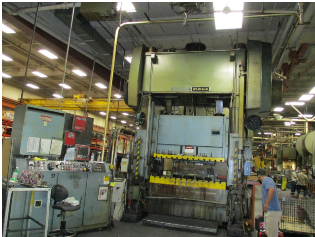
Prensa ABB Niagara 400T — montaje y nivelacion
