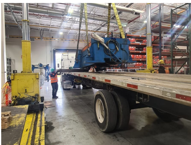
Detalle de instalacion en linea
